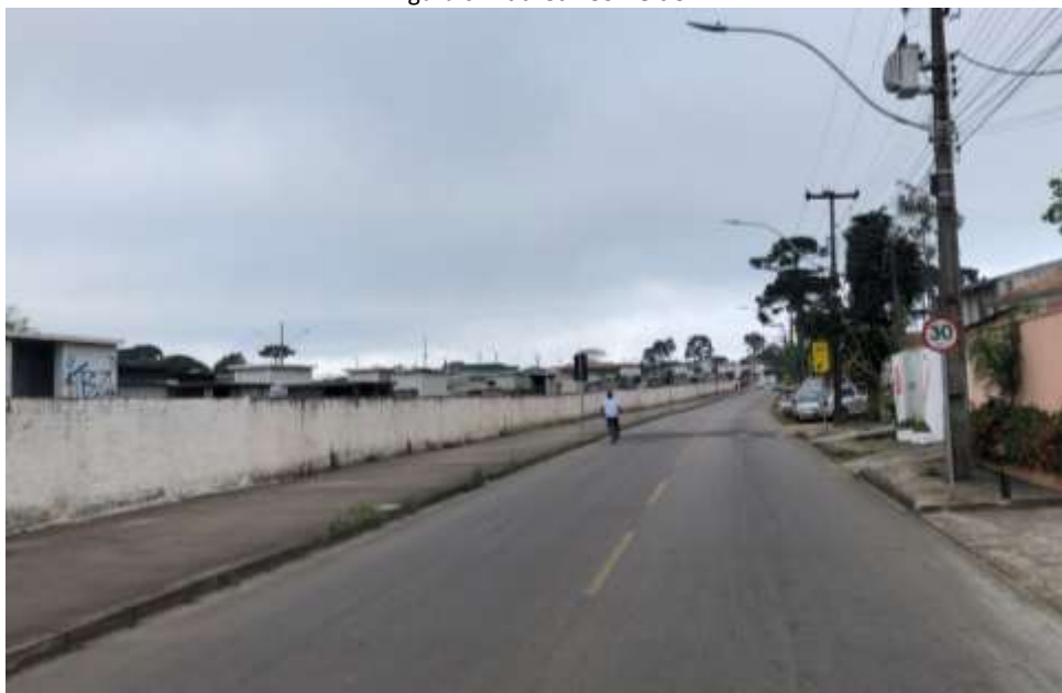
Figura 6: Rua Carlos Belão
