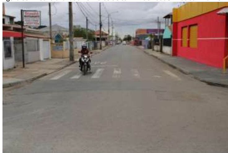
Figura 35: Trecho avaliado no índice de caminhabilidade - Rua Juri Danilenko
