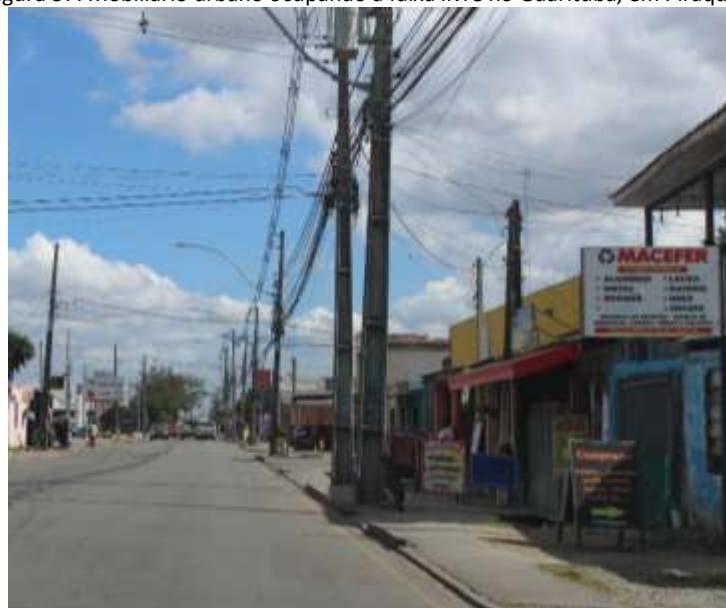
Figura 57: Mobiliário urbano ocupando a faixa livre no Guarituba, em Piraquara
