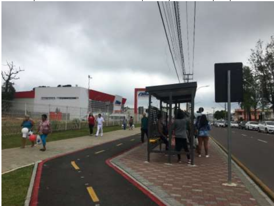
Figura 77: Exemplo de desvio de ciclofaixa em local de ponto de parada de transporte público em Piraquara
