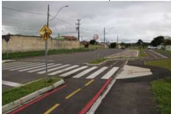
Figura 68: Exemplo de ciclovia no mesmo nível da pista de rolamento em Piraquara
