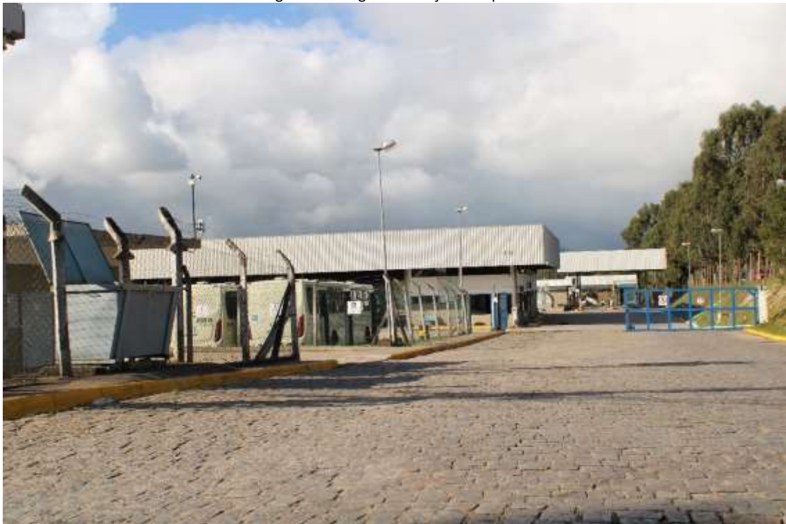
Figura 2: Garagem da Viação Piraquara
