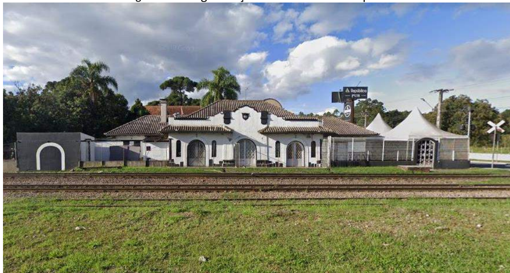
Figura 10: Antiga estação ferroviária de Piraquara
