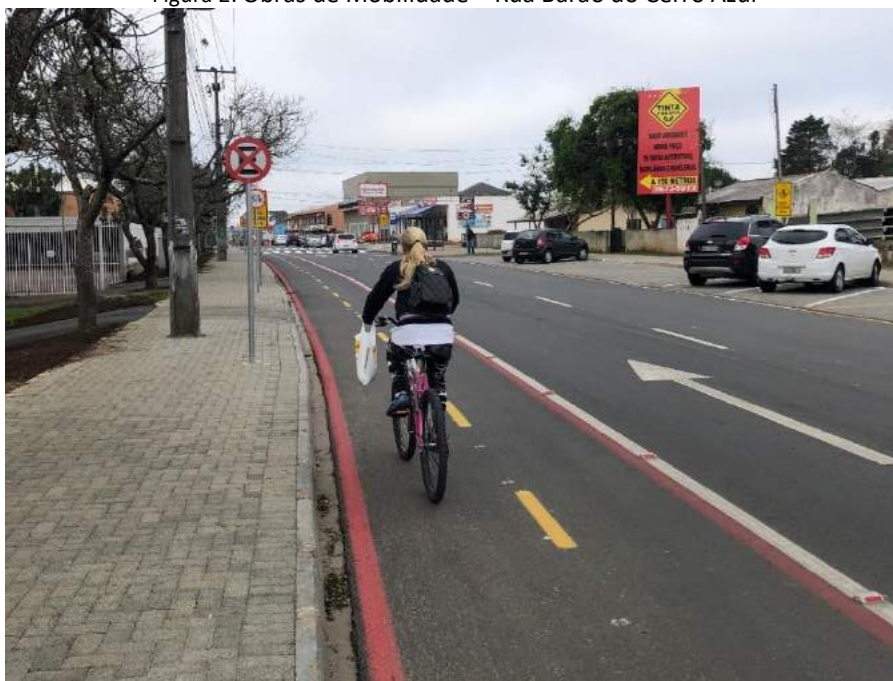
Figura 2: Obras de Mobilidade – Rua Barão do Cerro Azul
