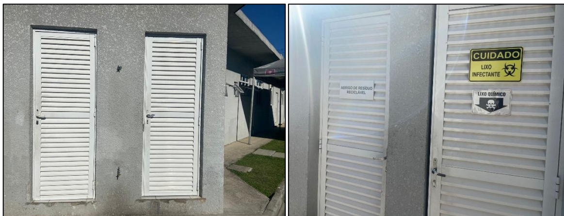
Figura 4 – Vista exterior dos locais de armazenamento externo.
