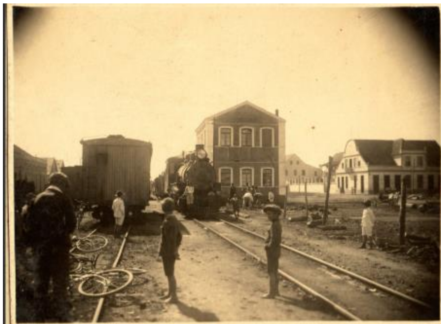
Figura 2 - Fotografia da primeira estação ferroviária do município, no ano de 1924.
