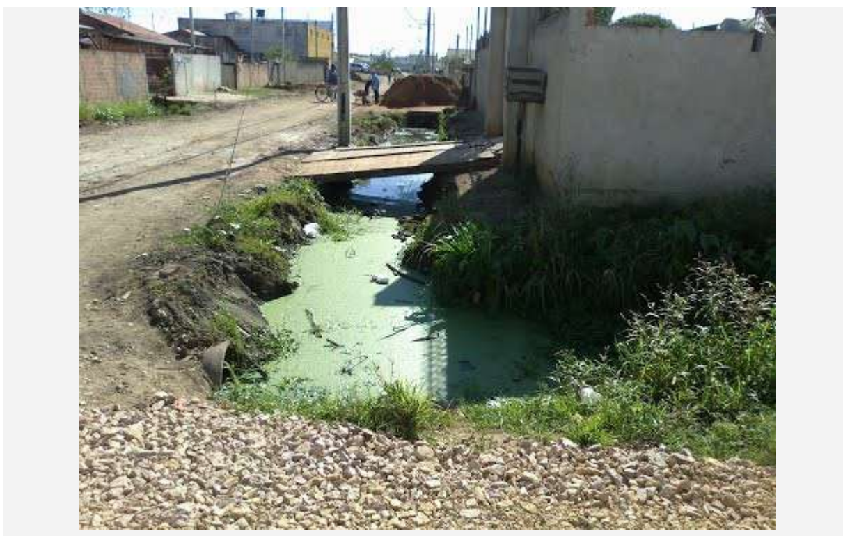
Imagem 05 – Esgoto Bairro Guarituba / Piraquara
